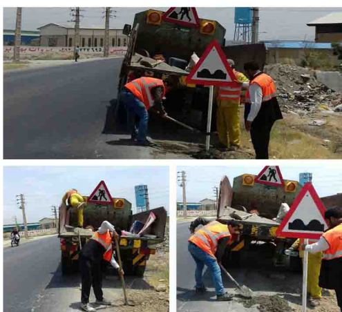
نصب تابلو علائم ایمنی در محور شهرک صنعتی نظرآباد - نجم آباد
