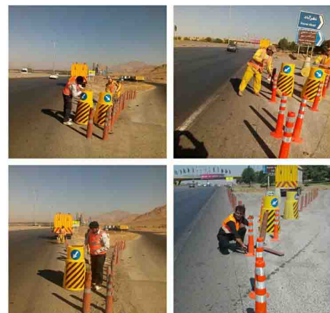
عملیات نصب بشکه و باتومی ایمنی در آزادراه کرج قزوین
