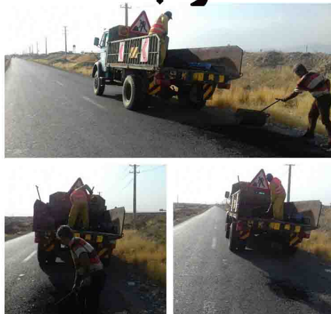
عملیات لکه گیری محور روستایی قاسم آباد
